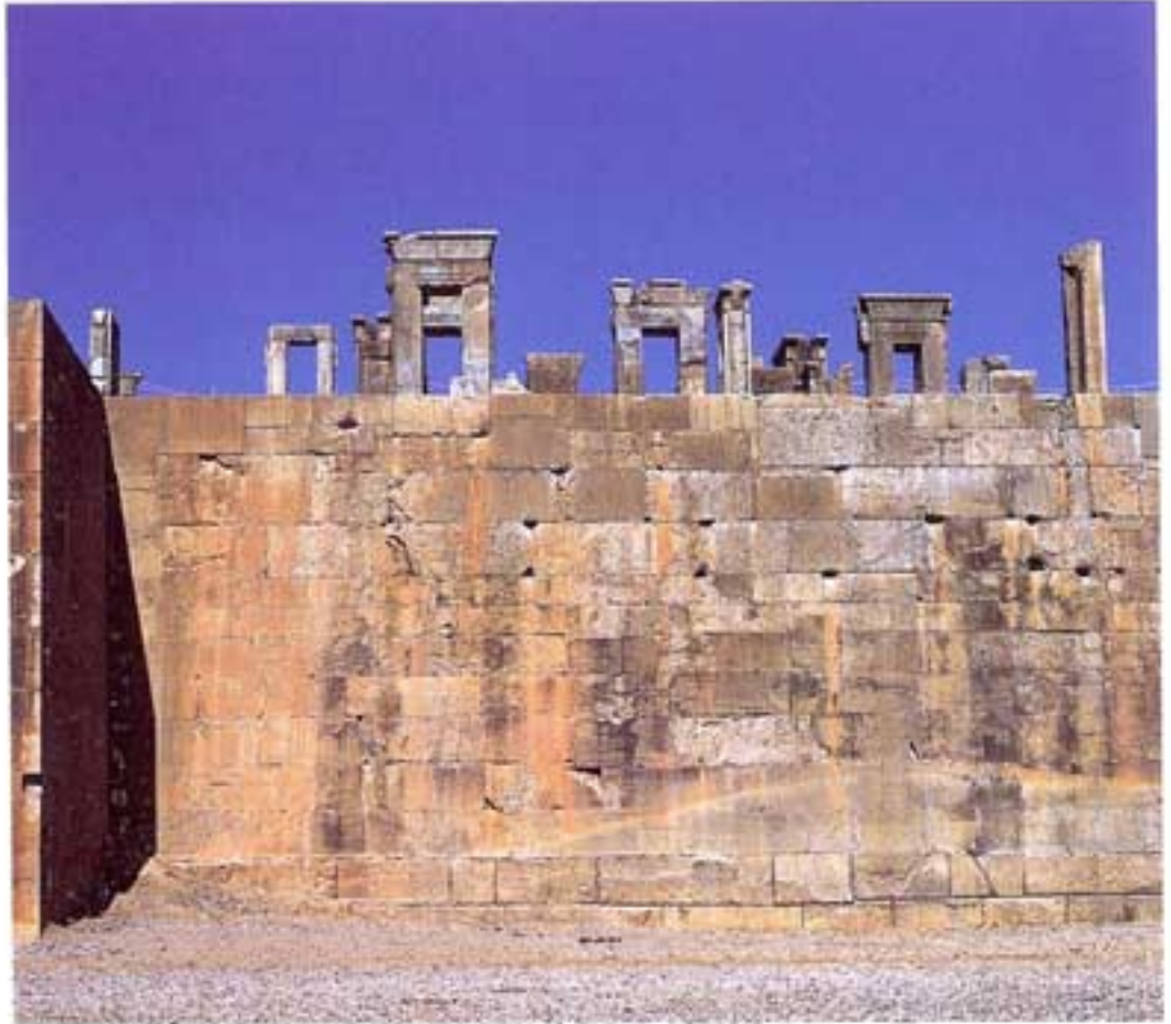
۲۸. دیوار غربی صفت: دیوار بعدی که به جبهه اصلی افزوده اند در تصویر پیداست.
