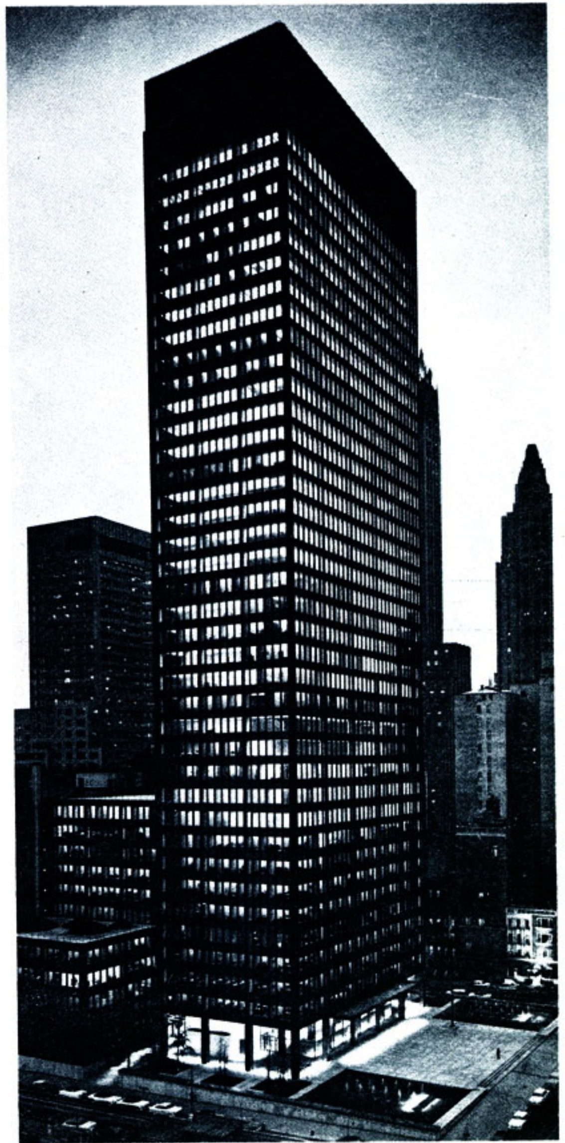
۷۹۲ لودویگ میس‌وان در روهه، ساختمان سیگرام، نیویورک، ۱۹۵۶-۱۹۵۸.
