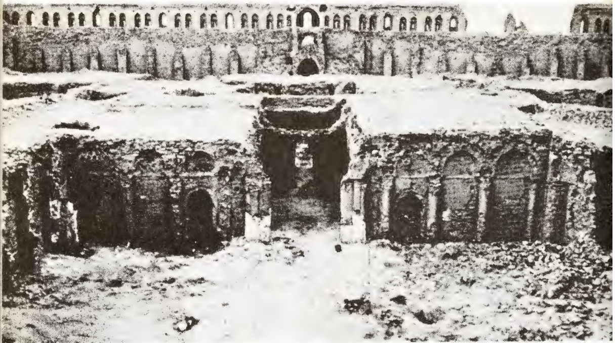
۲۳ - بغداد - نمای جنوبی حیاط بیرونی و حصار قصر «اُخیدر».
