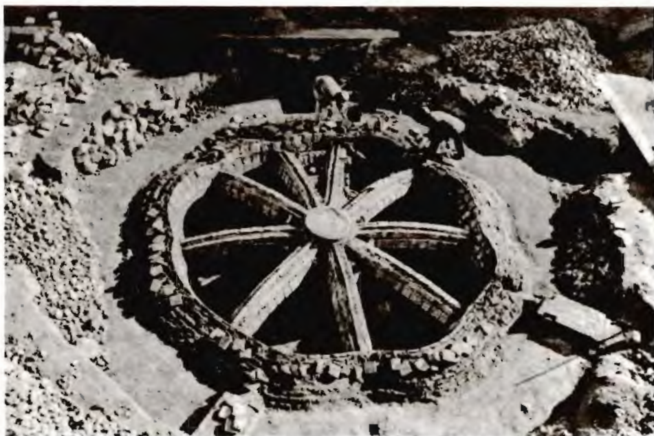
تصویر ۲۷۷- تبریز. ساختمان یک آب انبار
