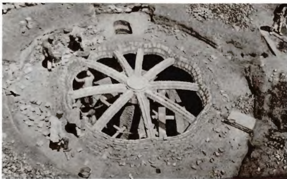
تصویر ۲۷۵- تبریز. ساختمان یک آب انبار
