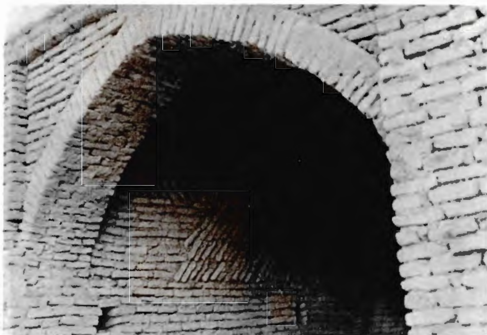
تصویر ۲۸۴- عباس آباد واقع بر سر راه شاهرود به مشهد. نمونه یک طاق گهواره‌ای که باخست خام و درخنده‌های خمیده ساخته شده
