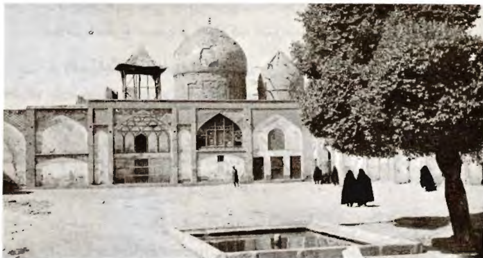
تصویر شماره ۱۸- درب امام- صحن شرقی
