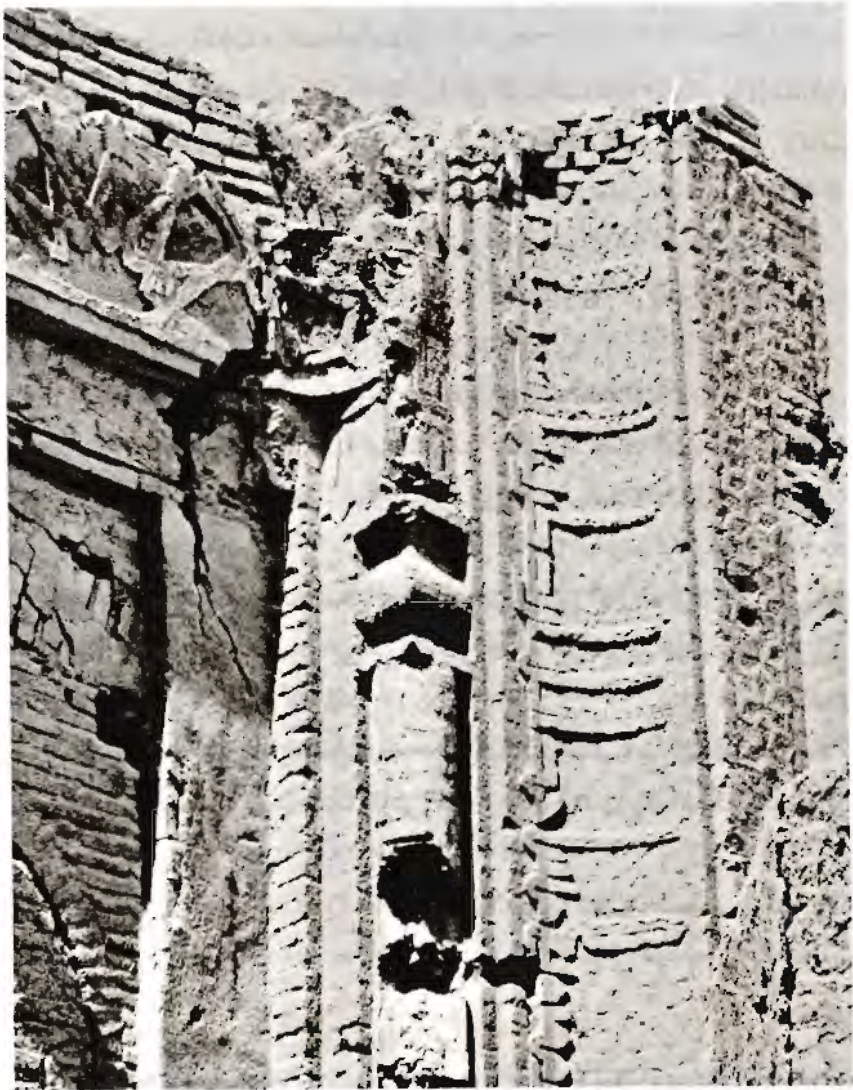
تصویر شماره ۲— مسجد جمعه— بخشی از دری که دارای تاریخ ۵۱۵ هجری است
