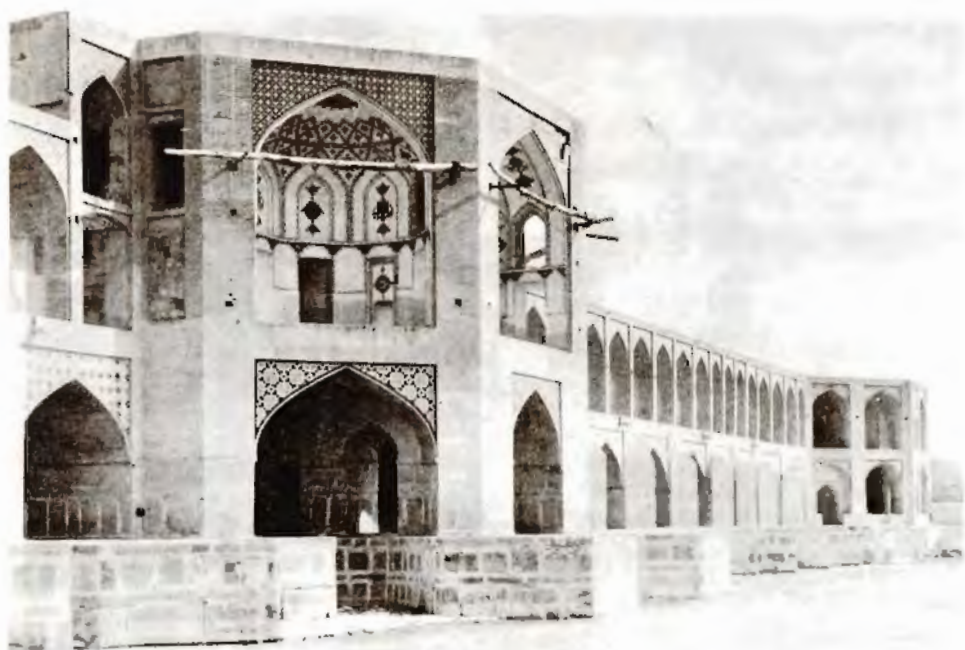
تصویر شماره ۵۱- پل خواجو
