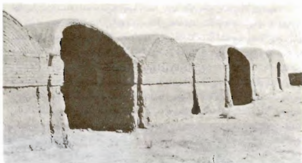
تصویر ۲۸۵ - ساختمانهای باطاق گهواره‌ای بر سرنایین به یزد
