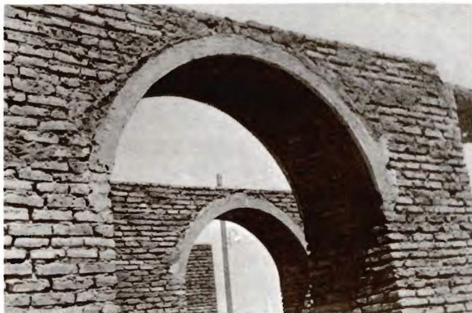
تصویر ۱۷۱- استفاده از یک سرطاق گچی مسلح به نی در ساختمان جدید
