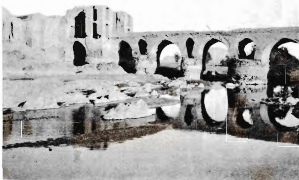
تصویر شماره ۵۲ - پل شهرستان
