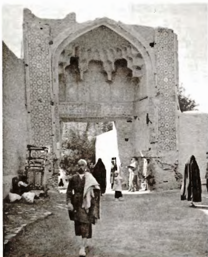
تصویر شماره ۲۰- درب کوشک
