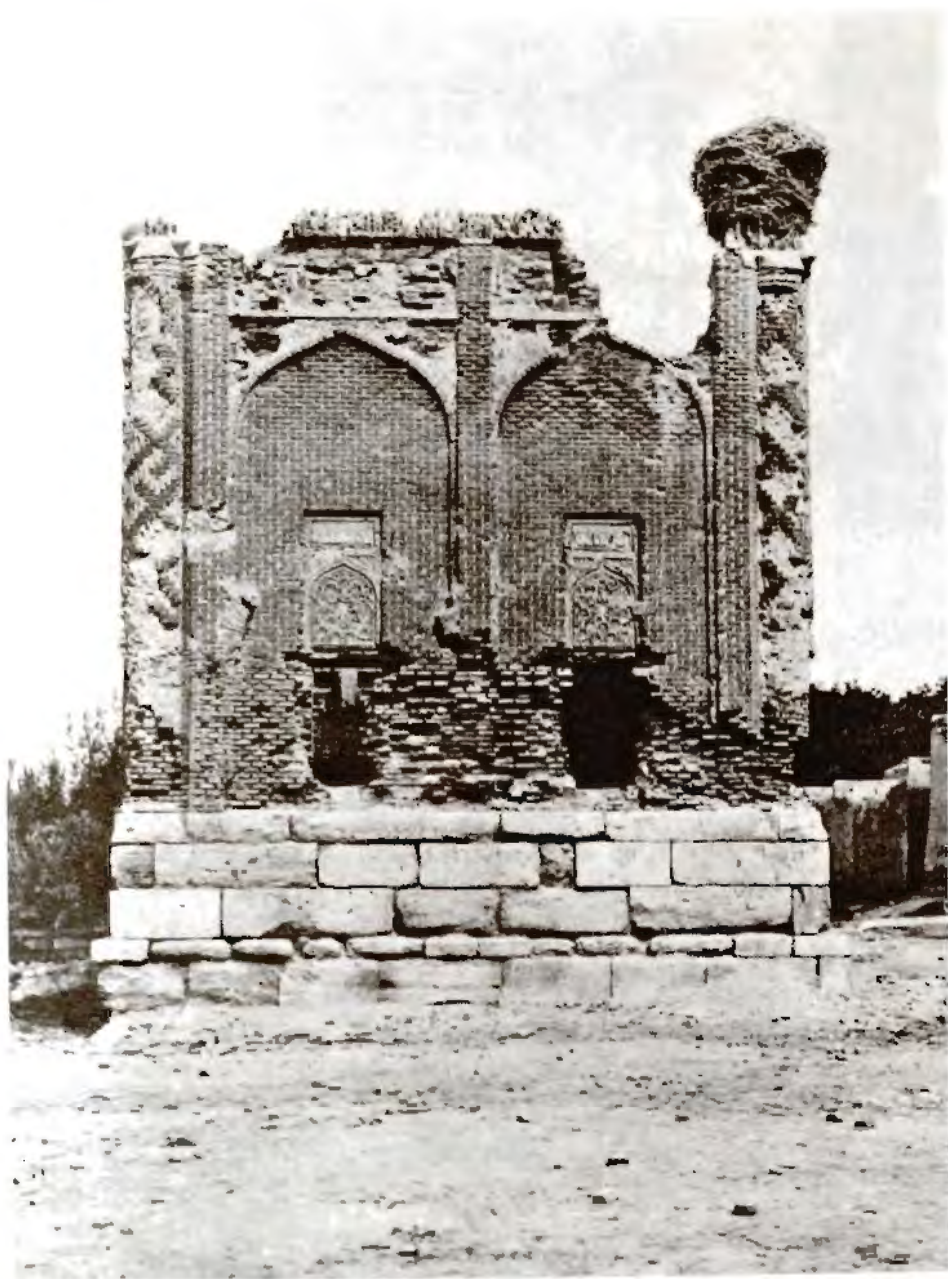
تصویر ۱۰۱- گنبد غفاریه، پشت ساختمان
