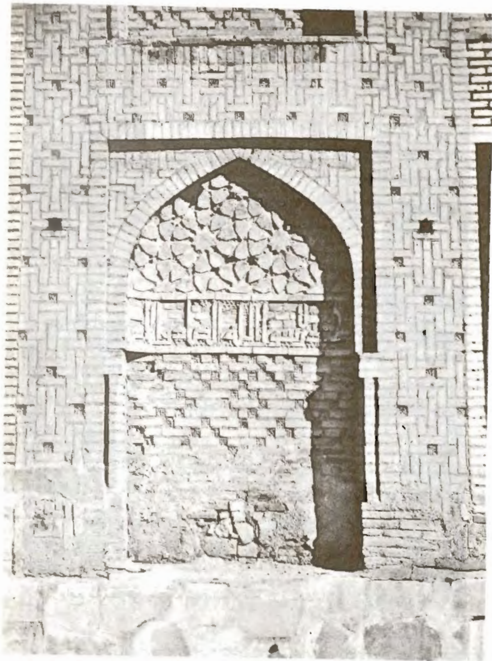
تصویر ۱۷۶- اصفهان- مسجد جمعه- بخشی از نمای ایوان شرقی
