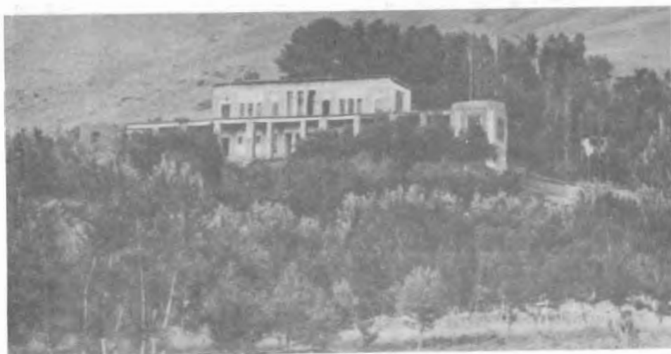
تصویر ۱۹۱ - جمال آباد - منظره کلی
