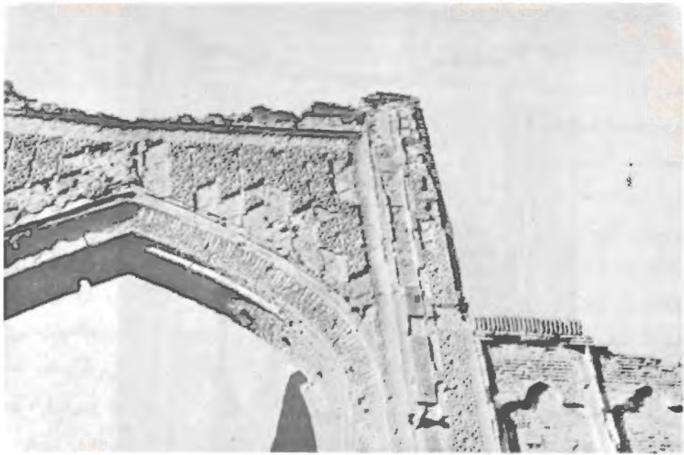
تصویر ۷۲- قسمتی از نمای ایوان اصلی مسجد فرمود
