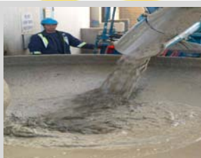
تصویر شماره ۳۱.۱۳. تخلیه بتن از ماشین Mixer
