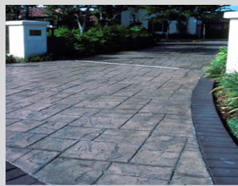
تصویر شماره ۱۳.۱۲. استفاده از سیمان پرتلند نوع ۱ در کف سازی
