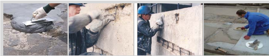
تصویر شماره ۱۳.۱۱. استفاده از ملات اپوکسی جهت ترمیم سطوح آسیب دیده
