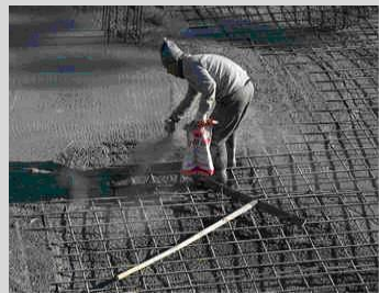
تصویر شماره ۱۴.۱۵. اجرای عایق رطوبتی ساخته شده بر پایه سیمان، بر روی سطح بتن
