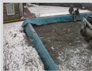
تصویر شماره ۳۵.۱۳. عمل آوردن بتن
