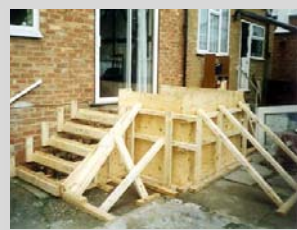
تصویر شماره ۳۳.۱۳. قالب بندی بتن
