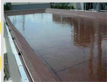
تصویر شماره ۱۸.۱۵. آزمایش عدم نشست آب در بام
