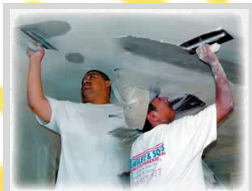
تصویر شماره ۹.۱۰. پرداخت نهایی سطح توسط گچ کشته
