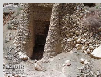
تصویر شماره ۱۰.۱۰. نمونه‌ای از کوره تنوره‌ای در گچسر
