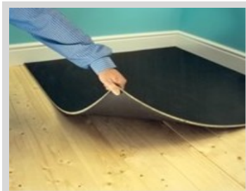
تصویر شماره ۵.۱۶. اجرای عایق صوتی بر روی کف
