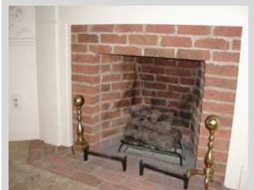
تصویر شماره ۴.۷. پوشاندن سطح داخلی شومینه با آجر نسوز
