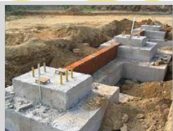
تصویر شماره ۱۰۱۳. فونداسیون بتنی
