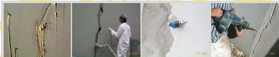
تصویر شماره ۱۴.۱۱. تزریق ملات در دیوار (از راست به چپ)
