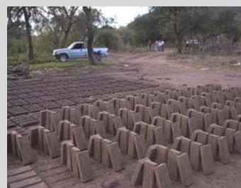
تصویر شماره ۶.۶. خشک کردن خشت به روش سنتی
