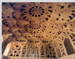
تصویر شماره ۳.۱۶. حفره‌های سقف تالار موسیقی عمارت عالی قاپو جهت جذب انعکاس صوت
