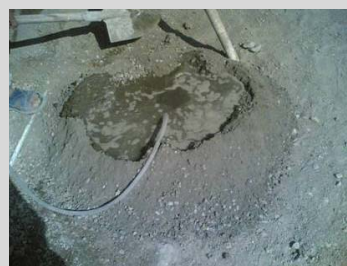
تصویر شماره ۵.۱۱. درست کردن آبخوره جهت ساخت ملات ماسه سیمان
