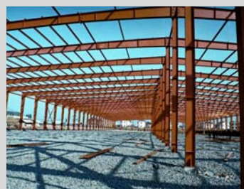
تصویر شماره ۱۴.۱۷. سازه فولادی
