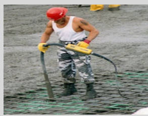
تصویر شماره ۳۴.۱۳. متراکم کردن بتن (ویبره کردن)
