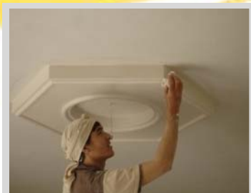
تصویر شماره ۲.۱۰. اجرای گچ‌بری‌های تزئینی بر روی سقف
