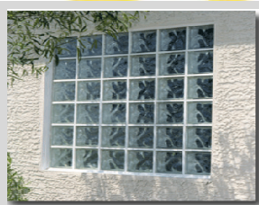
تصویر شماره ۲۴.۱۸. نمونه‌ای از اجرای آجر شیشه‌ای توپر
