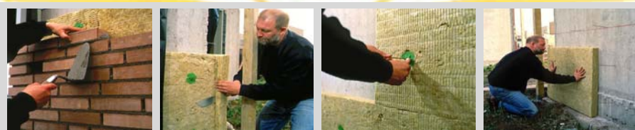
تصویر شماره ۳۶.۱۴. یک نمونه اجرای عایق حرارتی دیوار از سمت خارج (از راست به چپ)
