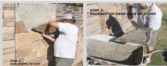
تصویر شماره ۳۶.۴. اجرای سنگ با ملات (در لبه‌های سنگ از ملات بیشتری استفاده می‌شود)
