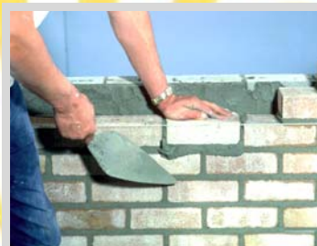
تصویر شماره ۲.۱۱. اتصال مصالح ساختمانی توسط ملات
