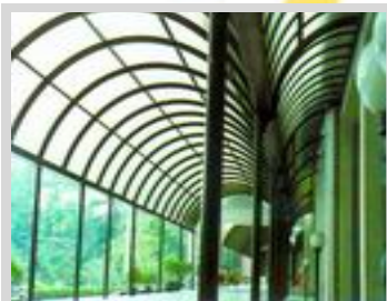
تصویر شماره ۱۲.۱۹. ساخت سقف‌های شفاف با ورق‌های پلی کربنات
