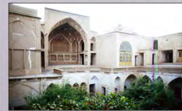
نمای شمال غربی
