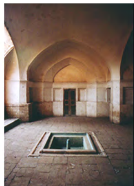
حوضخانه خانه بنی کاظمی (کا-۷)، در زیرزمین
